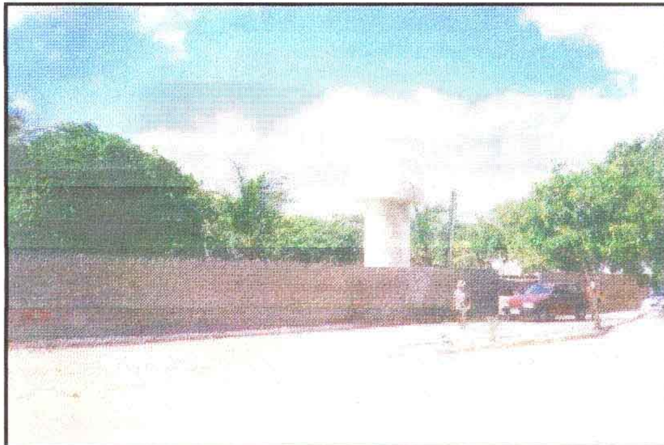
Foto 06 – Vista geral da área onde existem 02 poços amazonas secos e um reservatório elevado e que são utilizados no S.A.A. do distrito de Timbaúba dos Marinheiros.
